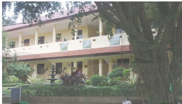
Gambar 3.2 Bangunan SMPN 2 Depok merupakan SBL
