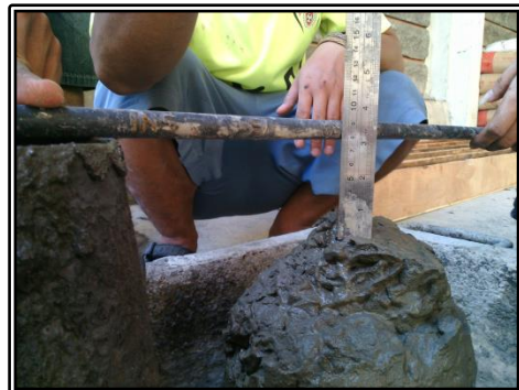
Pengujian Slump Adukan Beton
