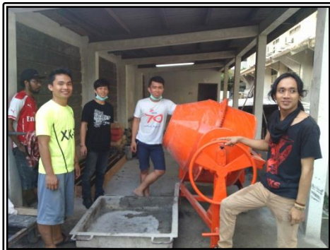
Proses Pembuatan Adukan Beton
