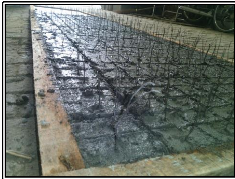
Pembuatan Tahu Beton
