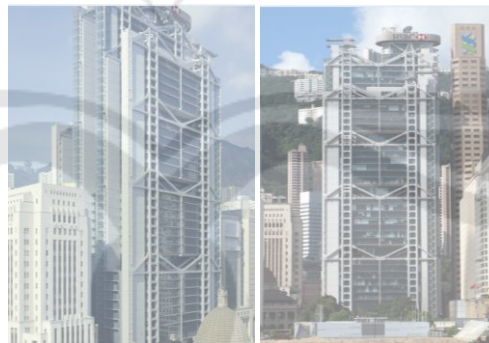
Gambar.6.13. Ekspos unsur linear pada sistem struktur Hongkong Bank
