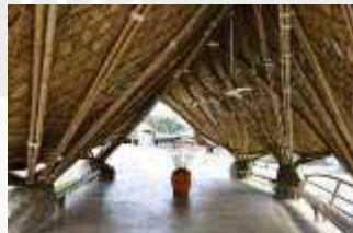
b) Kondisi dalam bangunan terlihat banyak kolom untuk menopang atap
