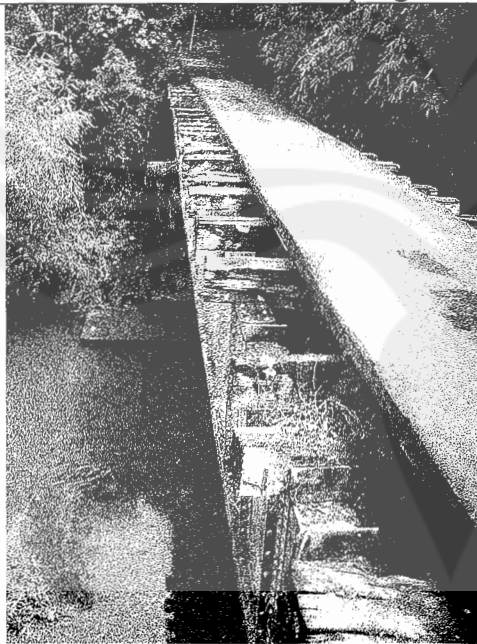
Gambar 5. Bekas Jembatan KA di Kasongan
