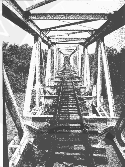
Gambar 9. Jembatan KA di Bengawan Solo
