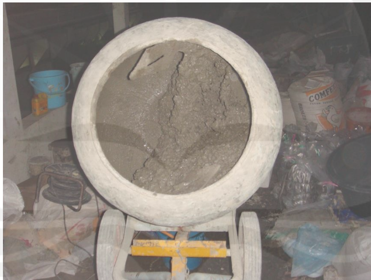
Gambar 4. Proses Pembuatan Adukan Beton
