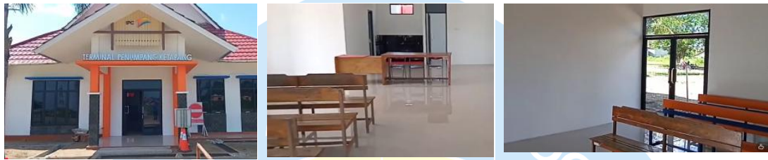
Gambar 1. 4 Hasil Rehabilitasi Terminal Penumpang Pelabuhan Sukabangun 2021
