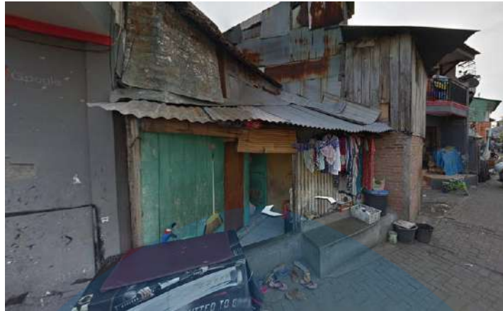
Gambar 1.1-4 Rumah yang berhimpitan satu sama lain (Sumber: Google Earth)
