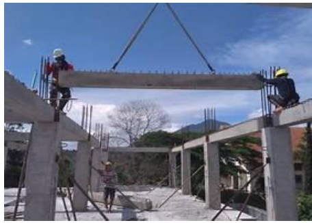
Gambar 5.14 Sistem Beton Pracetak
