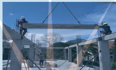
Gambar 2.15 Sistem Beton Pracetak
