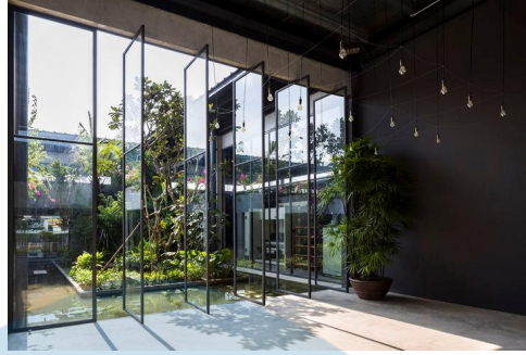
Gambar 5. 20 Pintu Pivot Lobby
