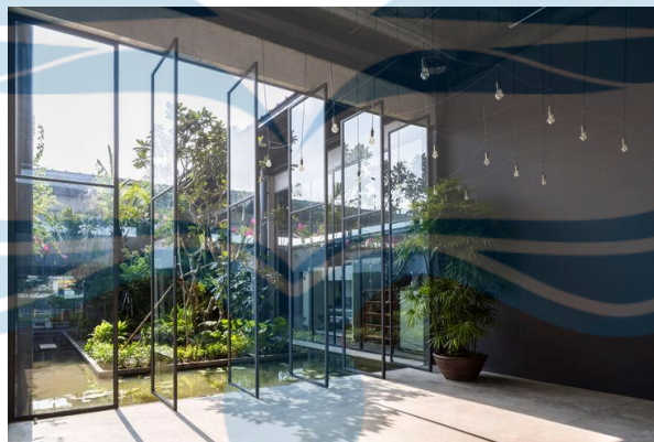
Gambar 5. 5 Pintu Pivot Lantai 1
