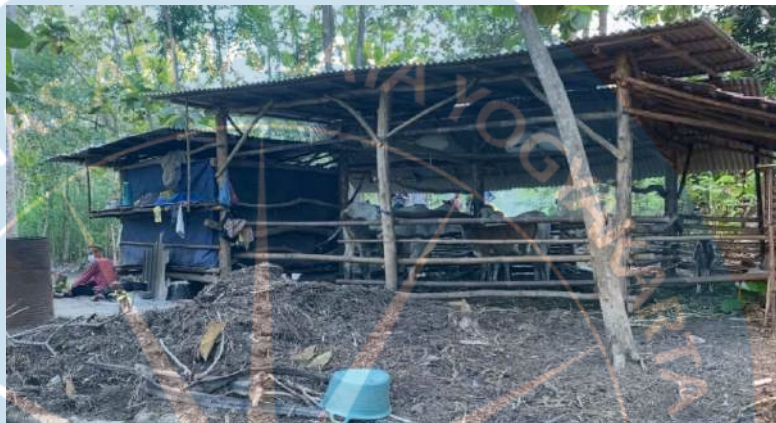
Gambar 2.2 Kondisi kandang sapi yang berdekatan dengan rumah warga di Gunungkidul menyebabkan bau tidak sedap Sumber: Mustaqim, 2021
