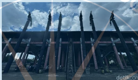
Gambar 2.25 Pilar Rumah Radakng
