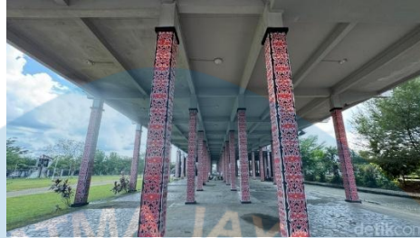
Gambar 2.24 Kolom Rumah Radakng
