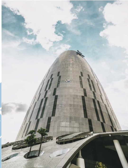
Gambar 2. 1 Gedung UMN Sumber : Sky Venture
