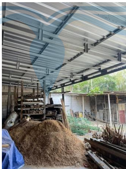
Gambar 1.2 Penumpukan Serbuk Kayu
