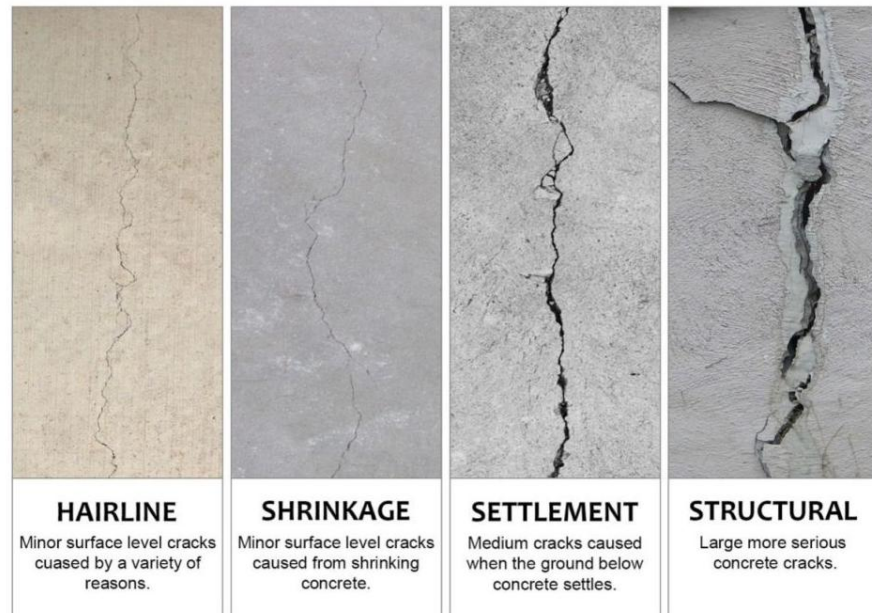
Gambar 2. 2 Jenis-Jenis Retak Beton
