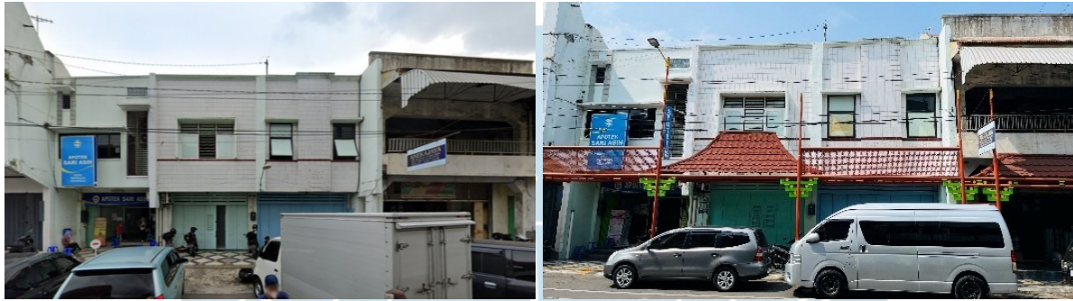
Gambar 1. 2 Kondisi koridor sebelum (kiri) dan sesudah penambahan elemen (kanan) (Sumber: Google Street View, 2022 ;Peneliti, 2024)
