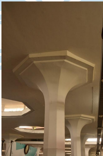
Lampiran 2. 4 Kolom Paddenstoelvloer pada Pasar Johar Sumber: Dokumentasi Pribadi, 2025
