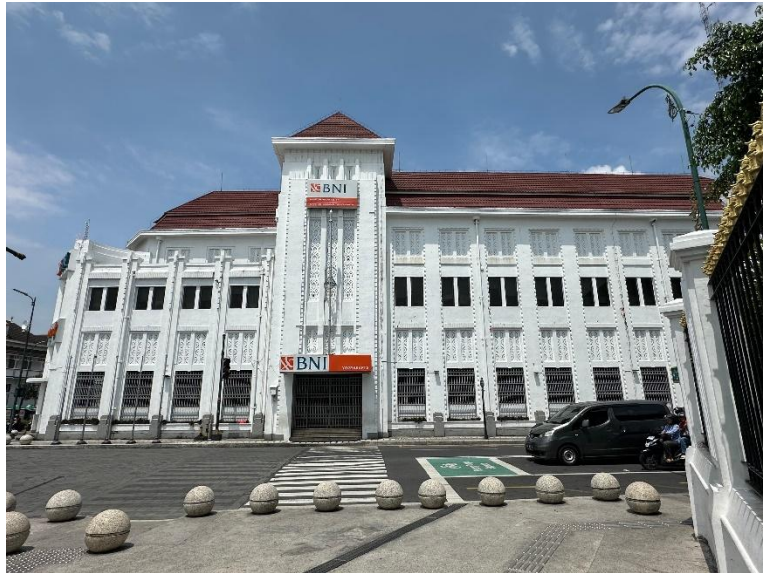
Lampiran 4. 3 Detail Menara Utama sisi Utara dan Bukaan pada fasad Sumber: Dokumentasi Pribadi, 2025
