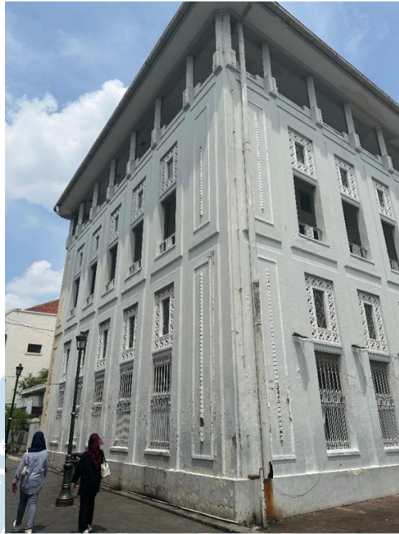
Lampiran 1. 3 Detail pada Sudut Gedung NILLMIJ Semarang Sumber: Dokumentasi Pribadi, 2025
