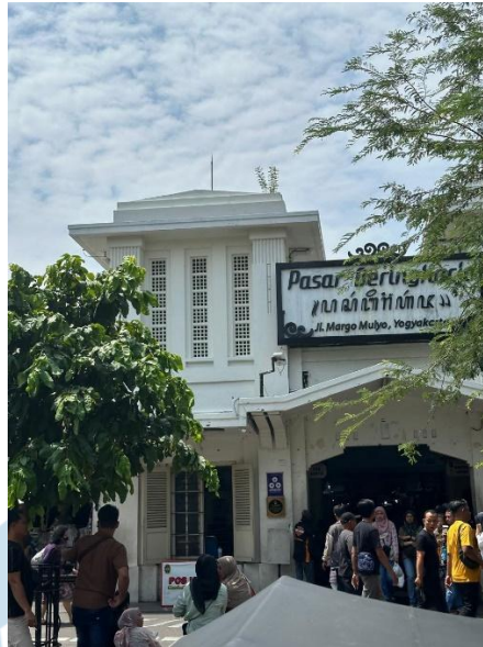
Lampiran 5. 3 Detail Menara pada Entrance Utama Pasar Sumber: Dokumentasi Pribadi, 2025
