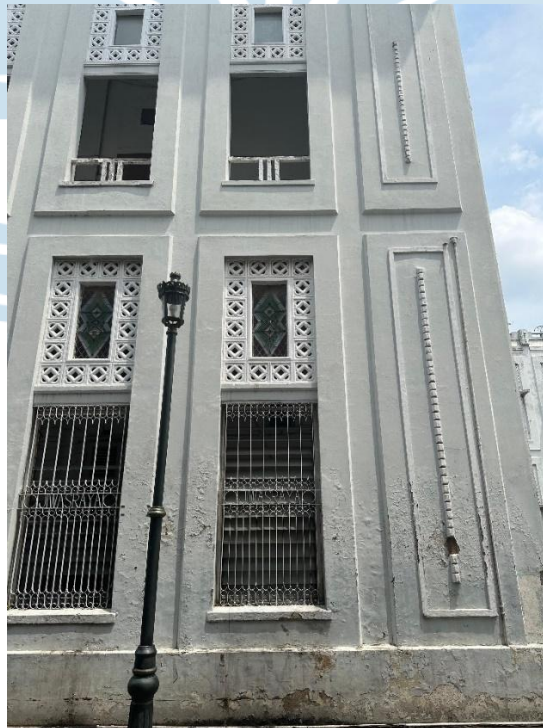
Lampiran 1. 4 Detail Bukan pada Gedung NILLMIJ Semarang Sumber: Dokumentasi Pribadi, 2025
