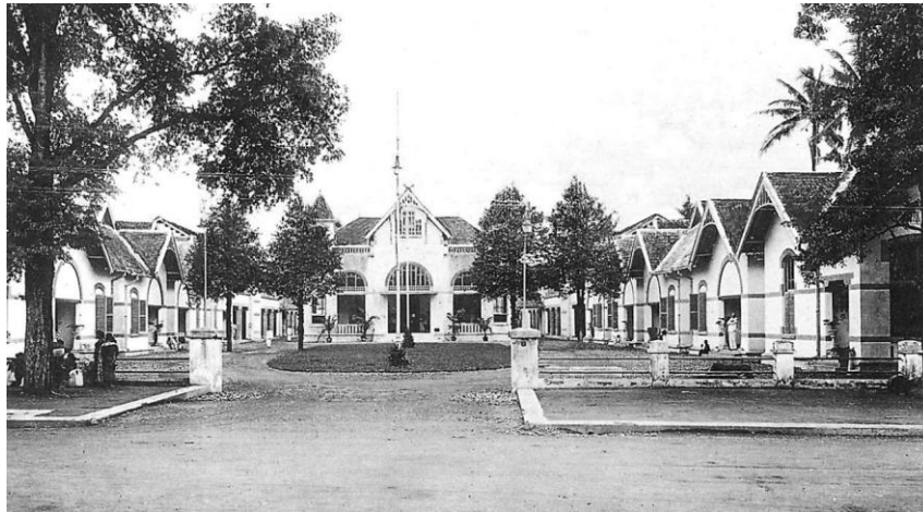
Lampiran 6. 1 Fasad Awal Hotel Inna Garuda Sebelum Perombakan Fasad Sumber: Norbruis, O.H. (2022). Arsitektur di Nusantara , hlm. 177.
