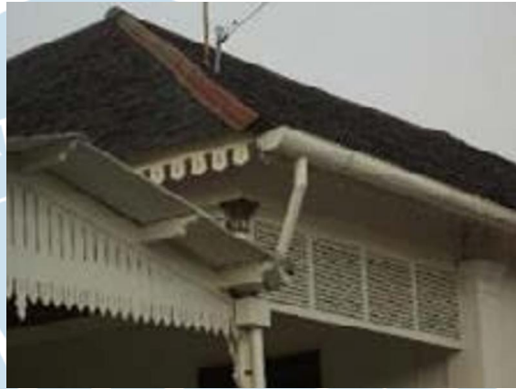
Gambar 2. 8 Gutter pada Bangunan Sasmitaloka, Bintaran Sumber: Kurniawan. (2022). Ensiklopedia Arsitektur Indis-Kolonial di Daerah Istimewa Yogyakarta
