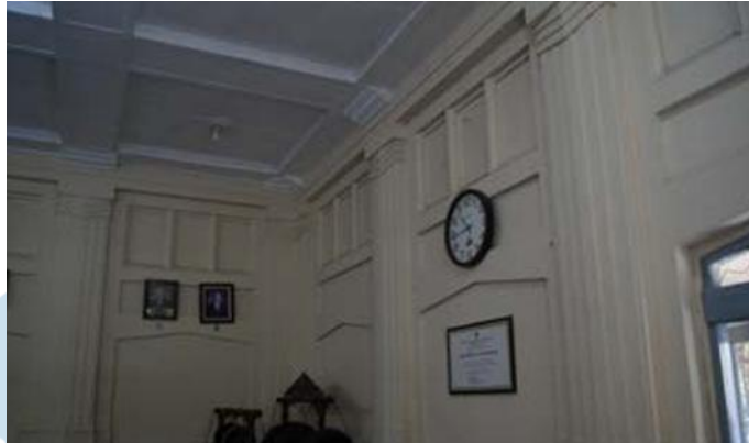
Gambar 2. 14 Pilaster pada Gedung SMA Negeri 3 Yogyakarta Sumber: Kurniawan.(2022). Ensiklopedia Arsitektur Indis-Kolonial di Daerah Istimewa Yogyakarta
