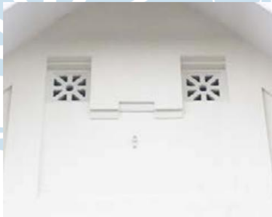
Gambar 2. 21 Roster pada Gable Bangunan Kolonial
