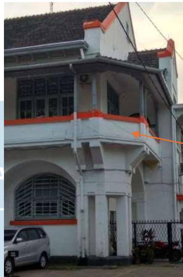
Gambar 2. 22 Balustrade pada Bangunan Kolonial
