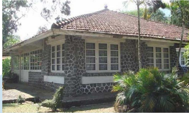
Gambar 2. 26 Penggunaan batu kali (Boulders) di Vila Merapi Indah Sumber: Kurniawan.(2022). Ensiklopedia Arsitektur Indis-Kolonial di Daerah Istimewa Yogyakarta
