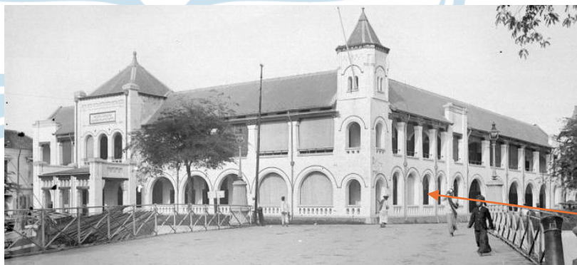
Gambar 2. 13 Archade pada Gedung Handelskantoort di Semarang Sumber: Google Images, diakses Maret 2025
