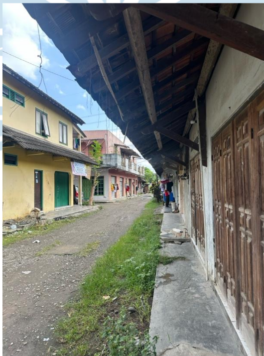
BANGUNAN YANG SUDAH MENJADI RUMAH
