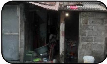
Rumah tidak layak
