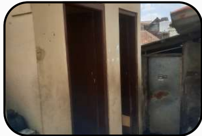
Toilet tidak layak
