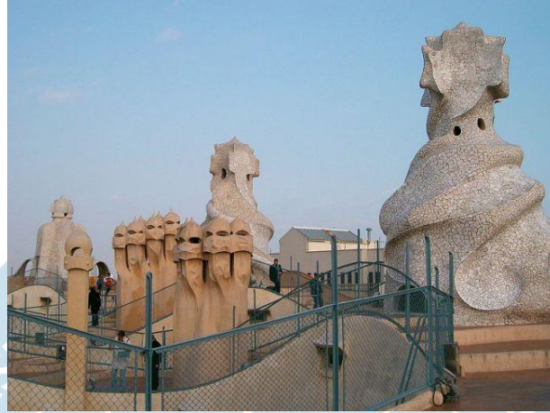
Gambar 2. 9 Cerobong Asap yang Berbentuk Patung di Atap Casa Mila Sumber : https://mariaoddylia.wordpress.com/2013/11/21/casa-mila/
