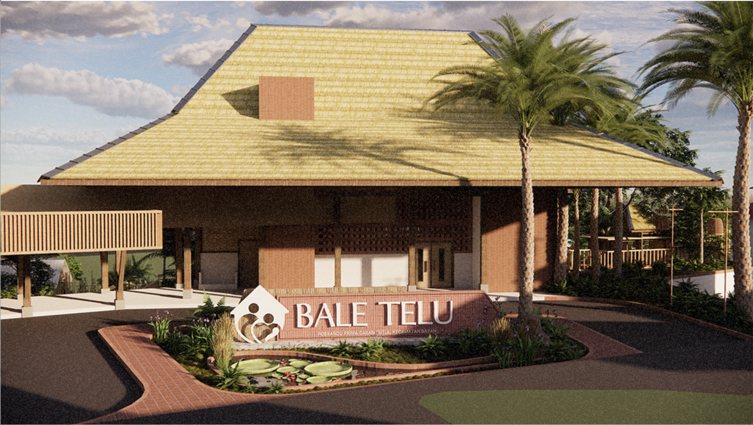
Tampak depan Bale Telu dengan signage utamanya. Material yang ditekankan yaitu material lokal seperti atap re (alang-alang), bata merah, bedeg dan kayu kelapa
