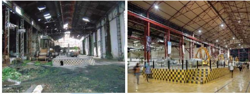
Gambar 2. 13 Konservasi Pabrik Sebelum (Kiri) dan Sesudah (Kanan)
