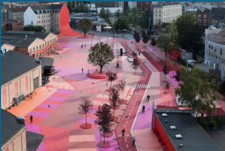
Gambar 30. Superkilen, Denmark, menggabungkan unsur budaya dan permainan kreatif [116].
