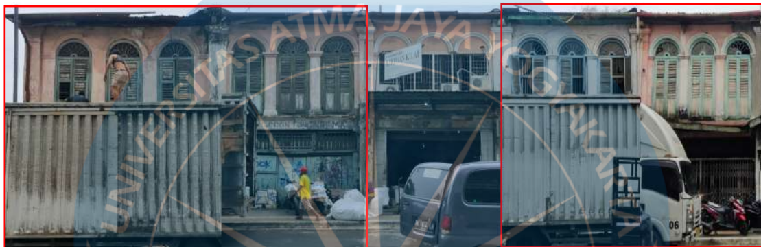
Gambar 1.1.3.2 Bangunan terbengkalai yang masih asli di Jalan GwangJu Sumber : Dokumentasi Penulis, 2024
