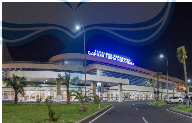
Gambar 38 Terminal Penumpang Gapura Surya Nusantara
