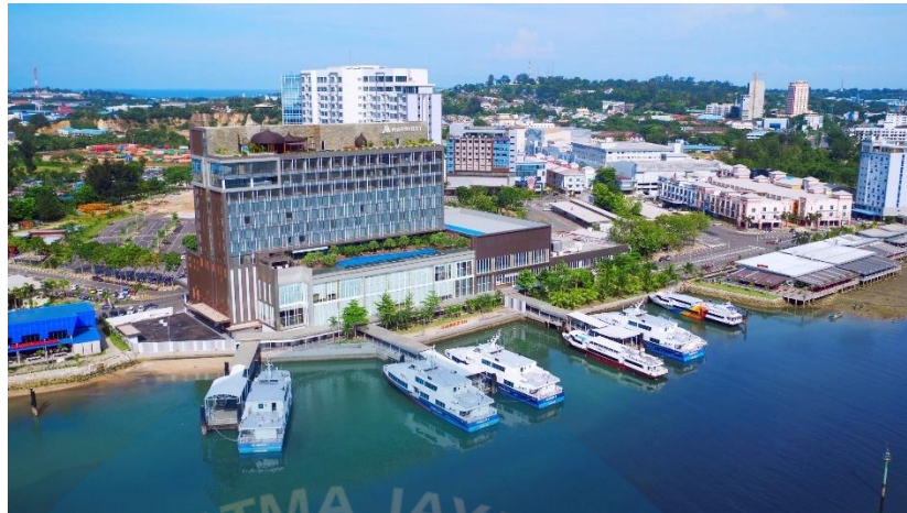
Gambar 35 Terminal Penumpang Pelabuhan Harbour Bay
