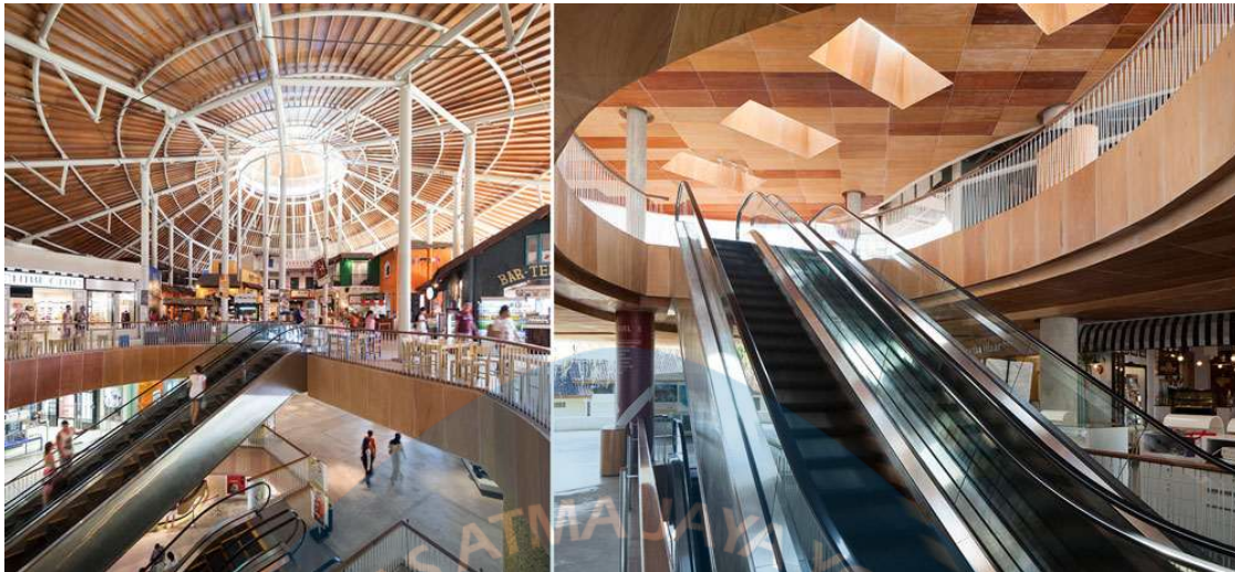
Gambar 57. Rangka Atap dan Plafon Beachwalk Shopping Center, Kuta, Bali Sumber: (envirotec, 2024)
