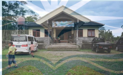
Gambar 8 Kondisi Bangunan Yayasan
