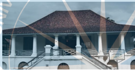
Gambar 1.17 Fasad Rumah Abu Kampung Kapitan
