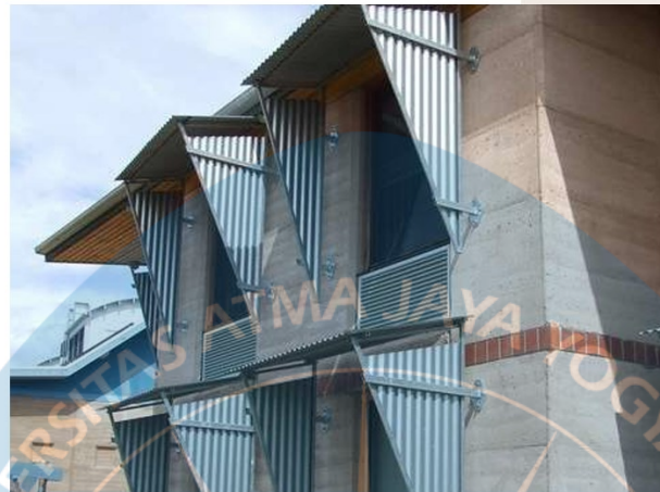
Gambar 2. 12 Shading overhang dan fins
