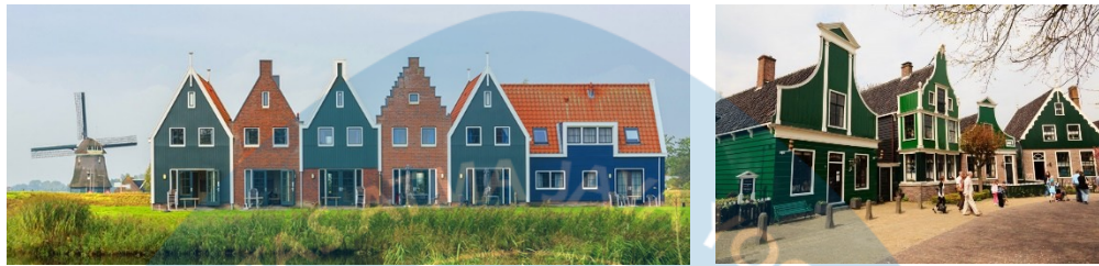
Gambar 8. Bangunan Tradisional Belanda
