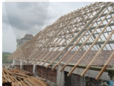
Gambar 6.10 Gambar Rangka Atap
