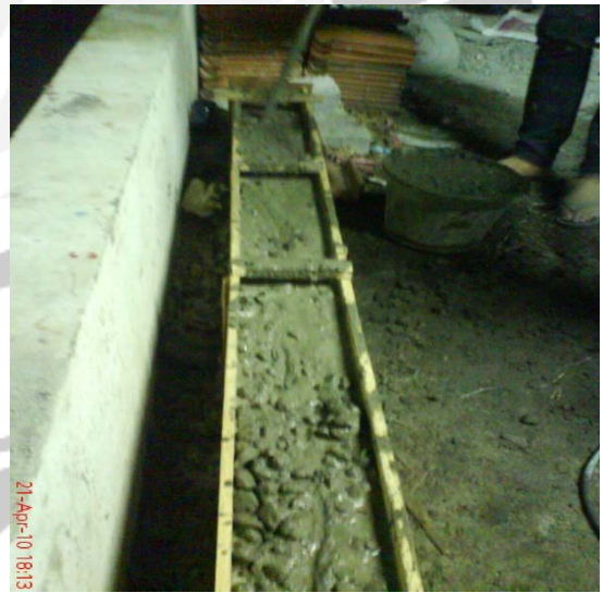
Foto : Pengecoran Balok Beton
