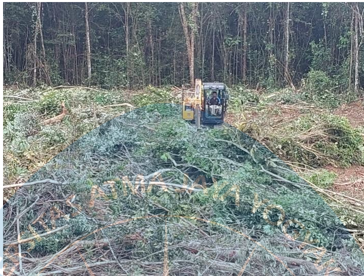
Gambar 1. 1 Alat Berat ( Excavator ) Saat Beroperasi
