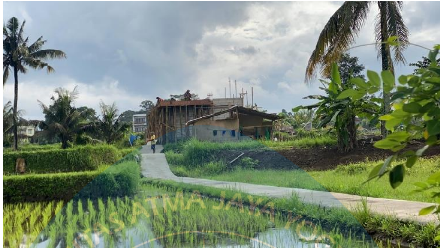
Gambar 17 Proses Pembangunan Diambil pada hari Jumat tanggal 5 Juni 2024
