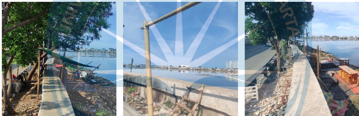
Gambar 5.6 Dinding Barrier Waduk Pluit
