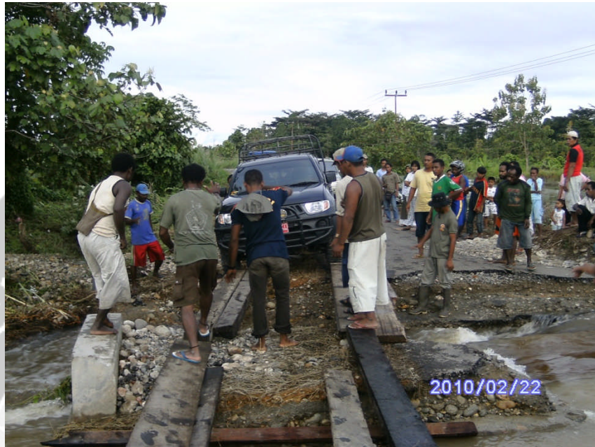
Foto 29: jalan yang rusak akibat banjir
