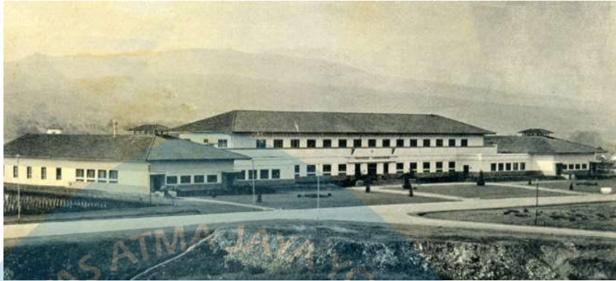
Gambar 2.11 Gedung Museum Geologi Bandung Tahun 1929
