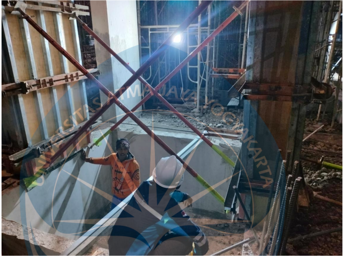
Gambar 2.17b Progres Pembangunan Pit Lift
