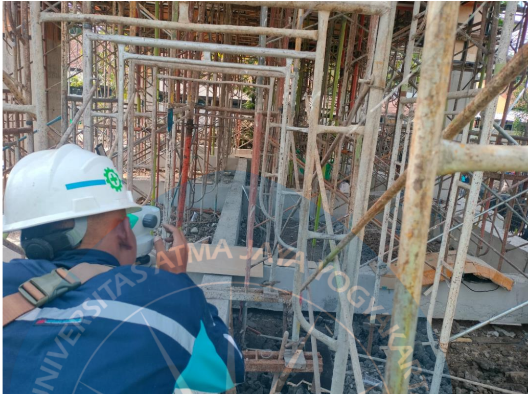
Gambar 2.2b Pengukuran Batas Bekisting Lantai Atas
