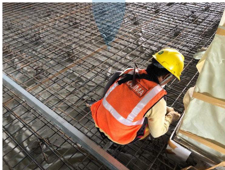
Gambar 2.14 Repair Penulangan Slab Setelah Checklist Penulangan
