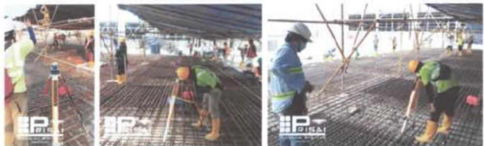
Gambar 2.17 Dokumentasi Pemasangan Relat
