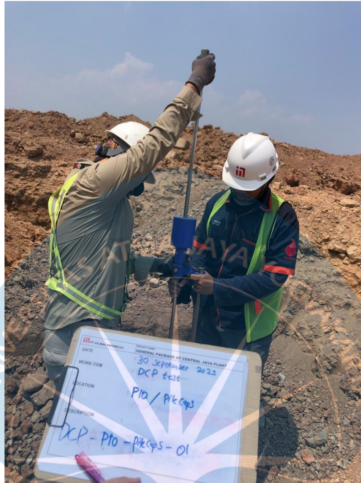
Gambar 2.26 Pelaksanaan DCP Test untuk Pile Caps
