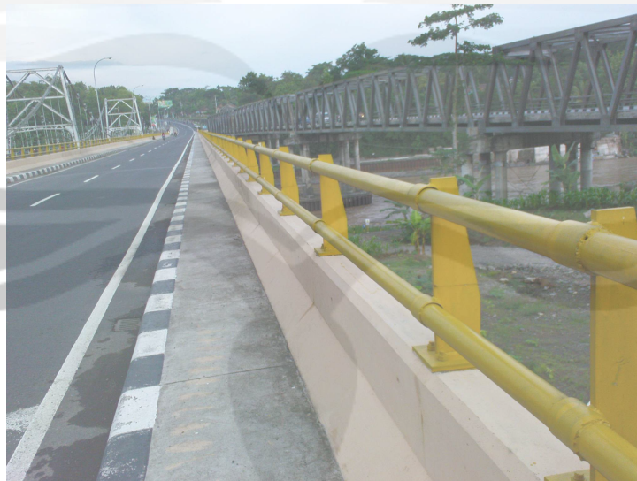
Gambar 2.18 Trotoar (Jembatan Bantar Jalan Sentolo – Milir Yogyakarta)
