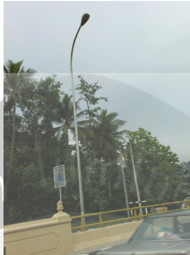
Gambar 2.17 Lampu Penerangan (Jembatan Bantar Jalan Sentolo – Milir Yogyakarta)
