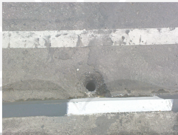
Gambar 2.14 Saluran Drainase (Jembatan Bantar Jalan Sentolo – Milir Yogyakarta)
