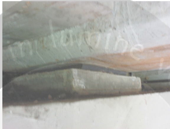
Gambar 2.9 Perletakan atau Andas (Jembatan Bantar Jalan Sentolo – Milir Yogyakarta)
