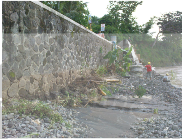
Gambar 2.15 Talud (Jembatan Bantar Jalan Sentolo – Milir Yogyakarta)
