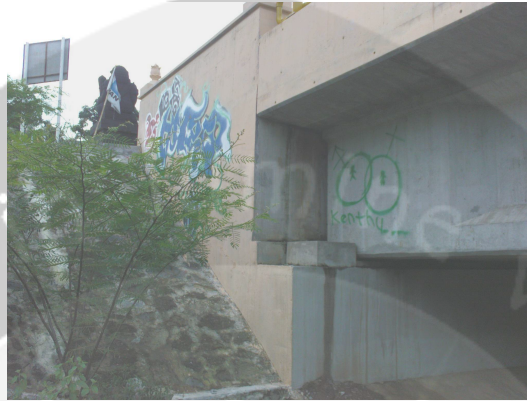
Gambar 2.12 Abutment (Jembatan Bantar Jalan Sentolo – Milir Yogyakarta)
