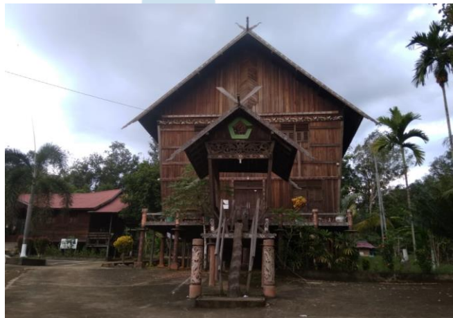
Gambar 4.19. Rumah Adat Dayak Jalai di Kampung Tanjung Sumber : Dokumentasi Penulis
