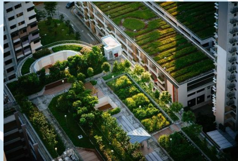
Gambar 59. Green roof pada atap bangunan
