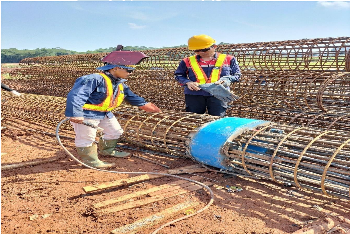
Pengelasan alat o-cell ke dalam besi keranjang
