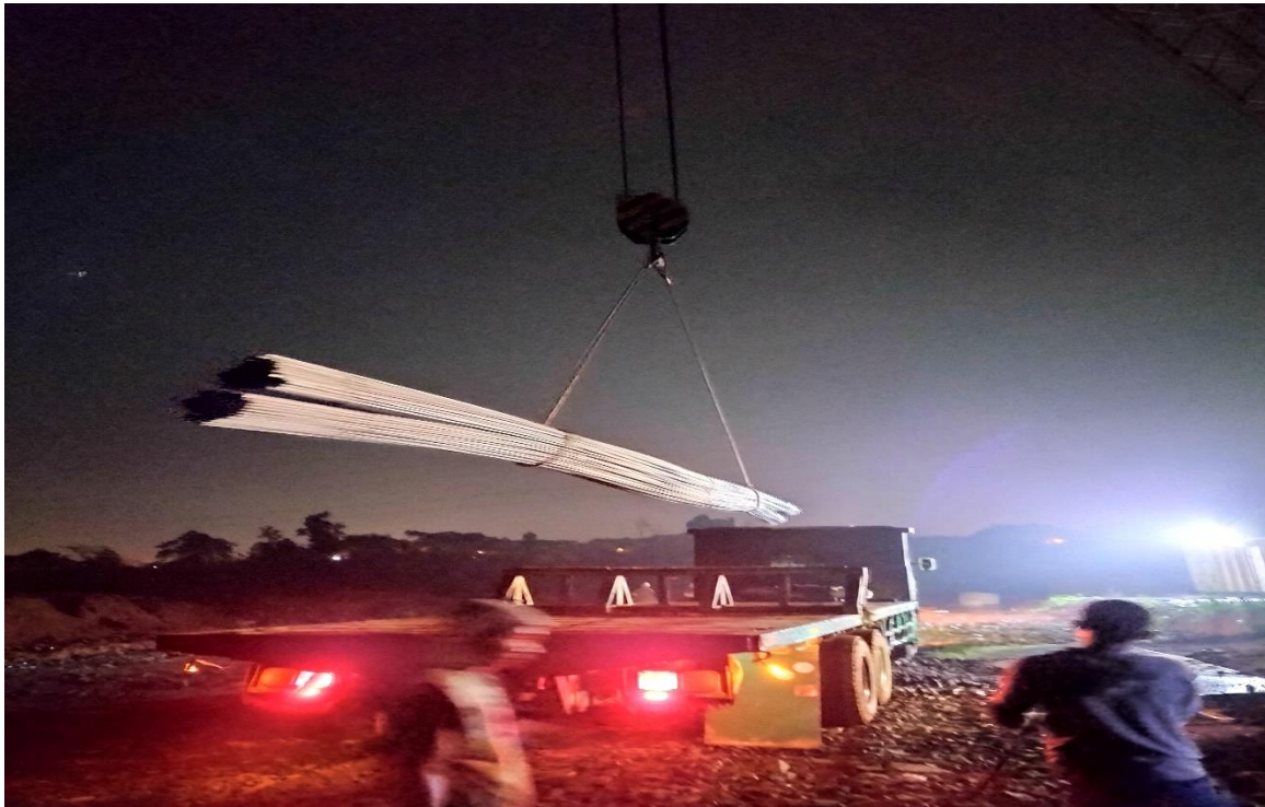
Pengangkatan material besi
