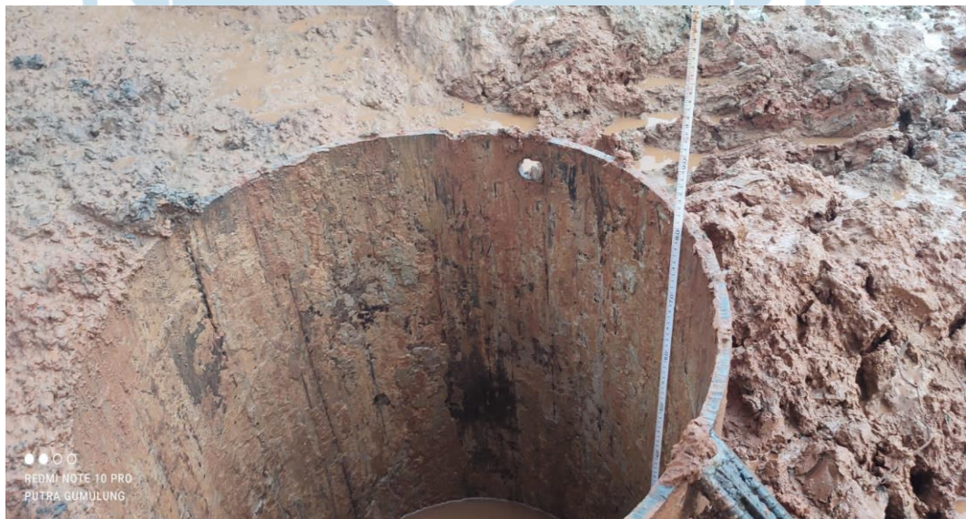
Cek kedalaman lubang bor
