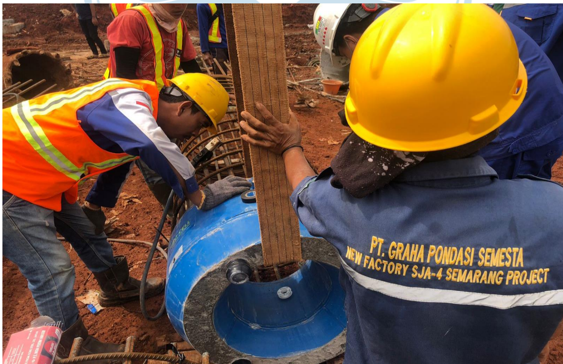
Penangkatan alat o-cell ke dalam besi keranjang
