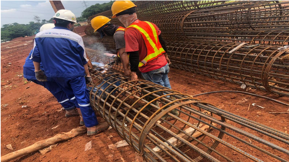
Pemasangan O-cell kedalam besi keranjang
