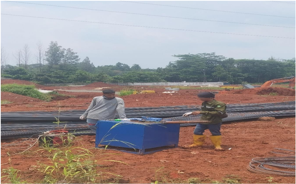
Pekerjaan bending tulangan
