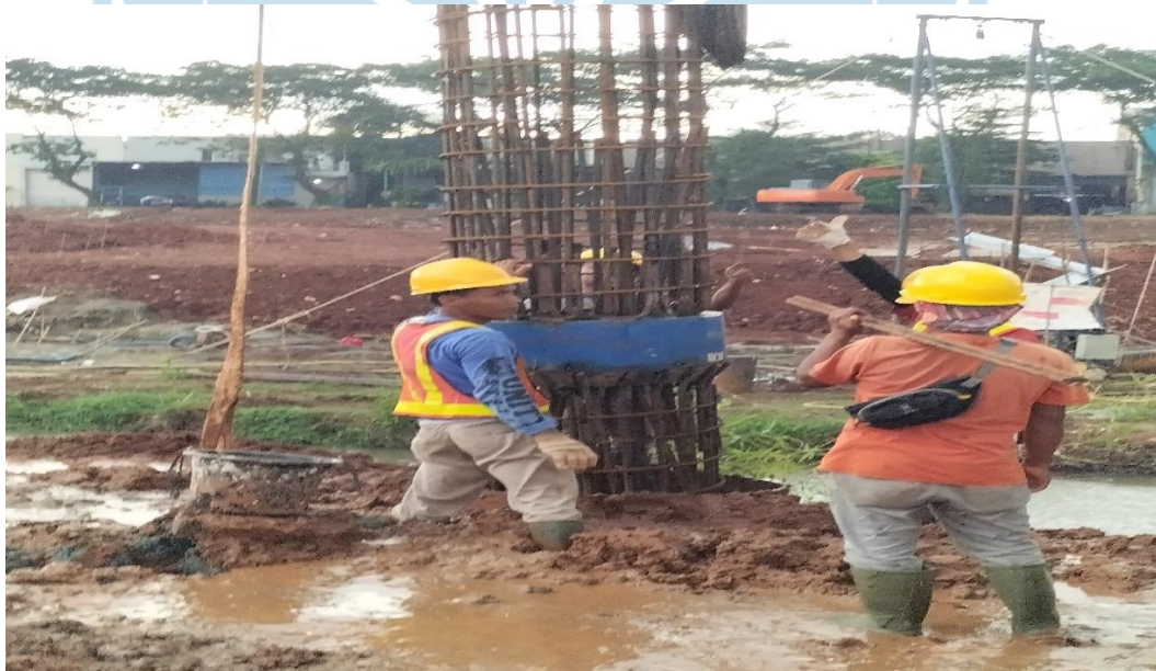
Pemasangan alat O-cell ke dalam lubang
