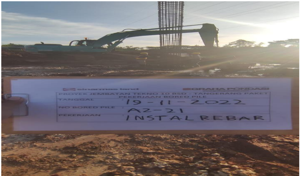
Dokumentasi monitoring pengecoran
