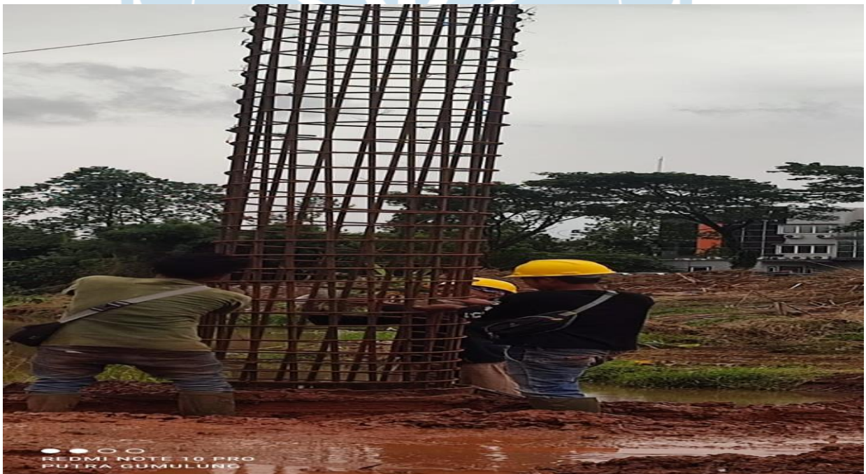
Instalasi besi keranjang kedalam lubang
