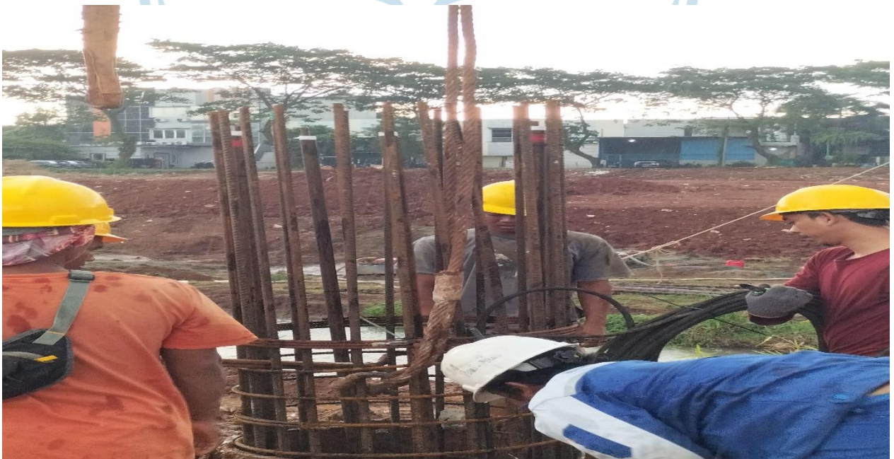
Pengelasan alat o-cell ke dalam lubang
