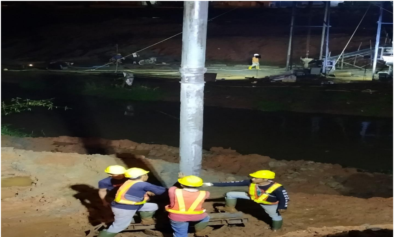
Instalasi pipa tremie ke dalam lubang
