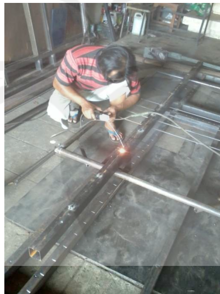
Pengelasan Kolom Langsing Kanal C Ganda
