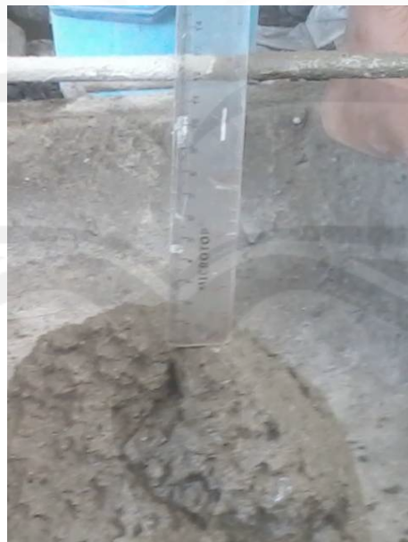
Slump Adukan Keempat
