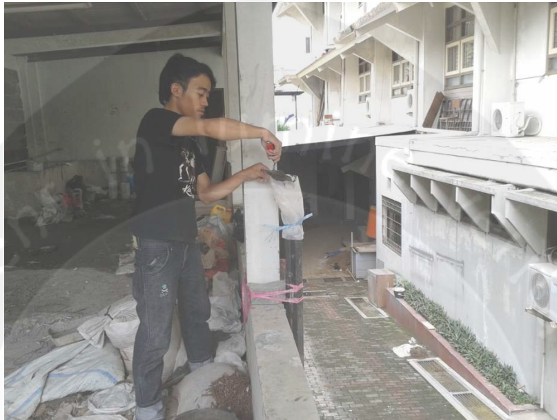
Pengecoran Kolom Langsing Kanal C Ganda
