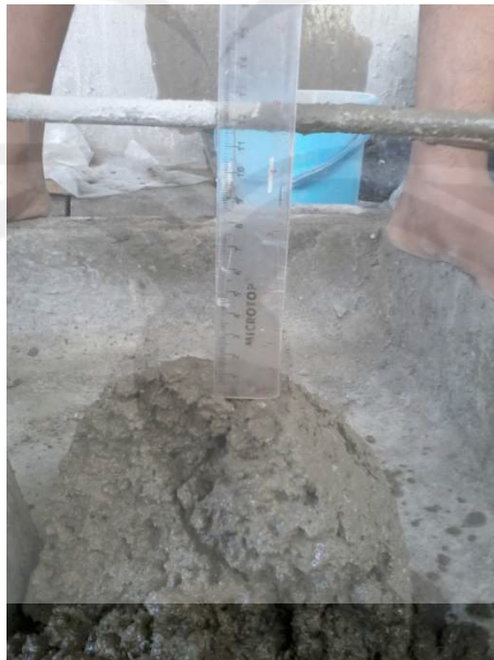
Slump Adukan Kedua
