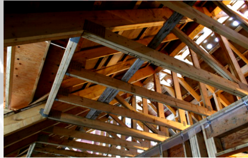
Gambar VI.37. Rangka Atap Kayu Sumber: www.doitpoms.ac.uk
