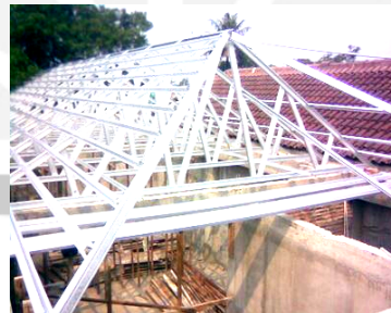
Gambar VI.38. Rangka Atap Baja Ringan Sumber: ciptapesonatruss.blogspot.com
