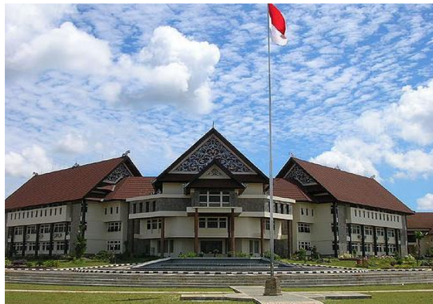
Gambar 1.1 Gedung Kantor Bupati Kutai Barat Sumber:
