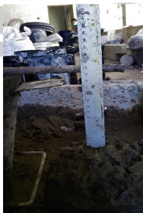
Pengujian Nilai Slump
