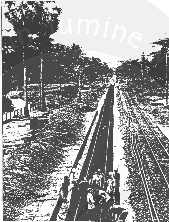
Gambar 2.13 Rekayasa Jalan Rel Kereta Api
