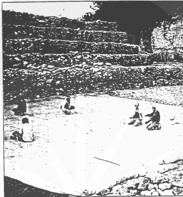
Gambar 2.12 Filter pada Perlindungan Pantai dan Tepian Sungai
